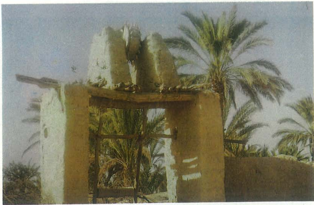
بئر لسقي الأشجار في بيت الحاج عقيل فكري بلنجة كان يستخدم الثور في إخراج الماء منه
