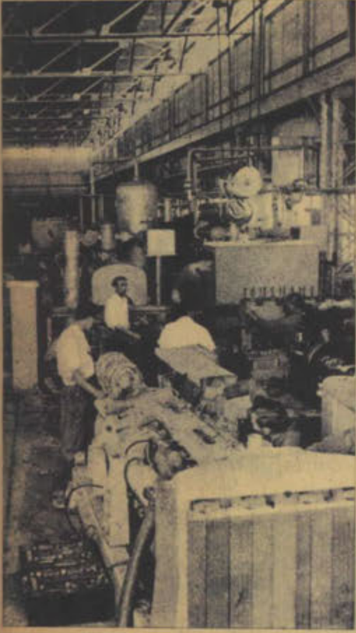
في محطة الكهرباء
