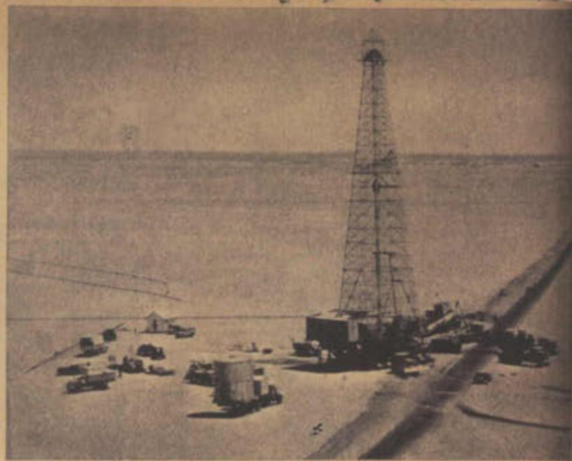
احد الابار اثناء عملية الحفر
