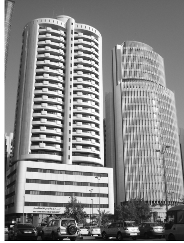
شكل رقم (٢٤) - برج الكورنيش ومبنى جهاز أبوظبي للاستثمار
