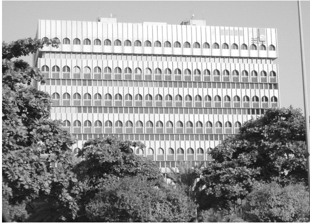
شكل رقم (٢٣) - مبنى شركة بترول أبو ظبي الوطنية- أدنوك
