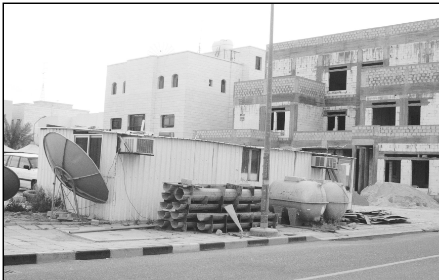
صورة رقم (٩) - بناء غير مرخص لا يتناسب مع بيت قيد الإنشاء
