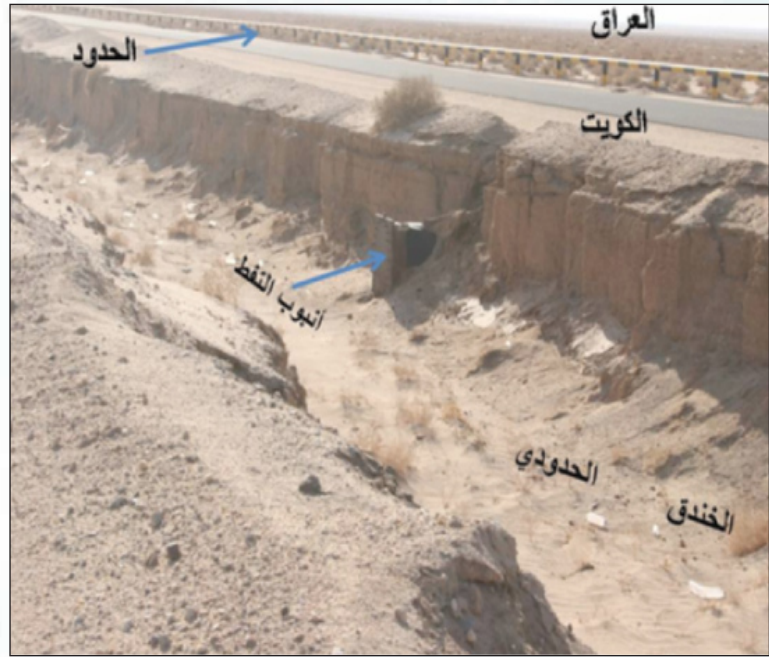
لوحة رقم (١) صورة حديثة توضح الخندق الحدودي وأنبوب النفط
